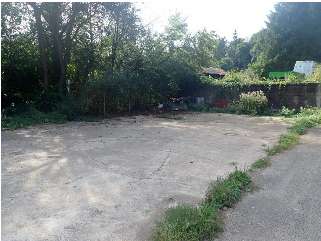
Bild 16: Vollständig versiegelte Flächen sind im Gebiet weitläufig vorhanden, hier am Nordrand von Parz. 1915
