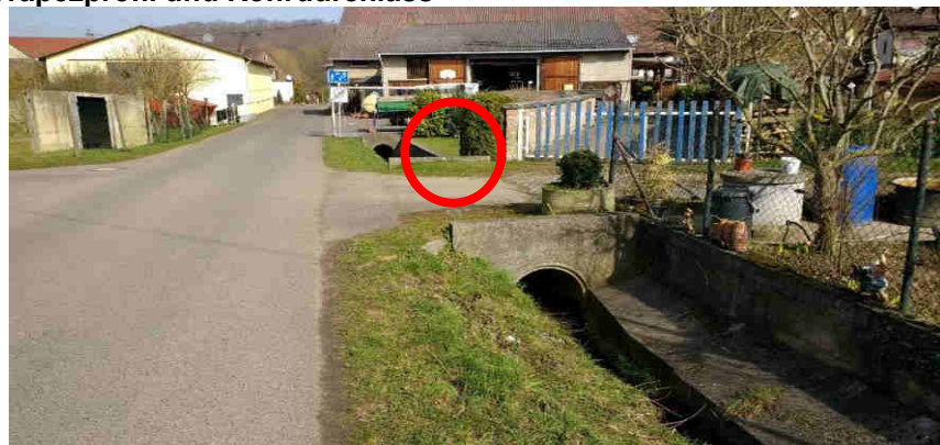
Abbildung 34: Hagenbach, Einlauf in verrohrten Abschnitt DN 800
