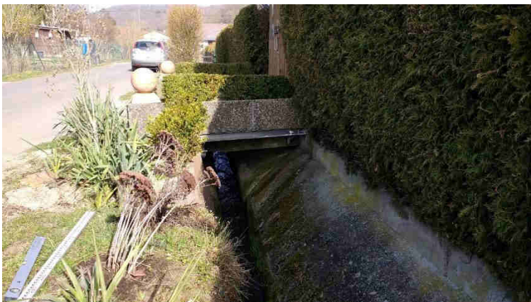
Abbildung 30: Hagenbach, Trapezprofil und Überfahrt
