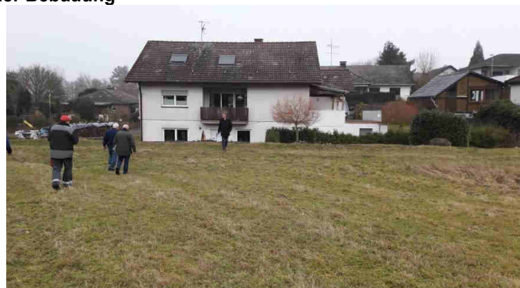
Abbildung 12: Rohrbach, gefährdete Bebauung
