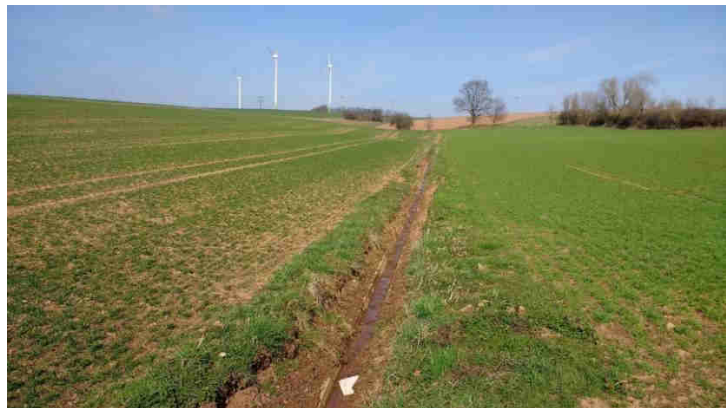
Abbildung 19: Münchwiesenbach, Graben mit Halbschale
