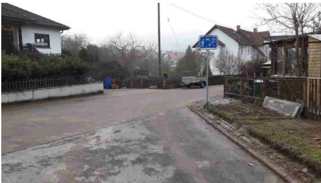
Abbildung 23: Münchwiesenbach, verrohrter Abschnitt Hauptstraße
