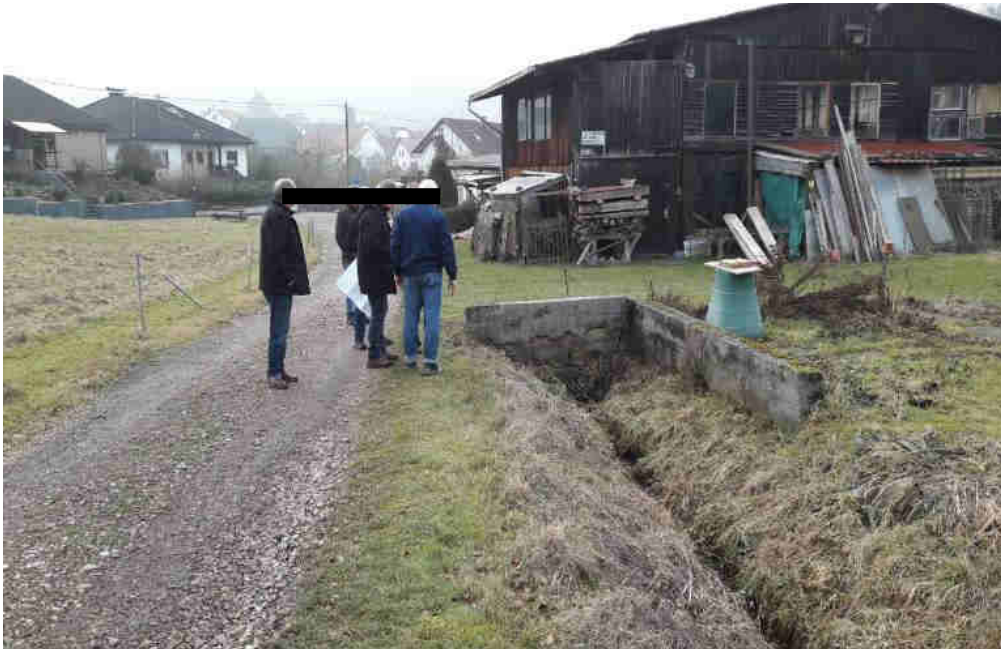
Abbildung 22: Einlauf in die Verrohrung DN 400
