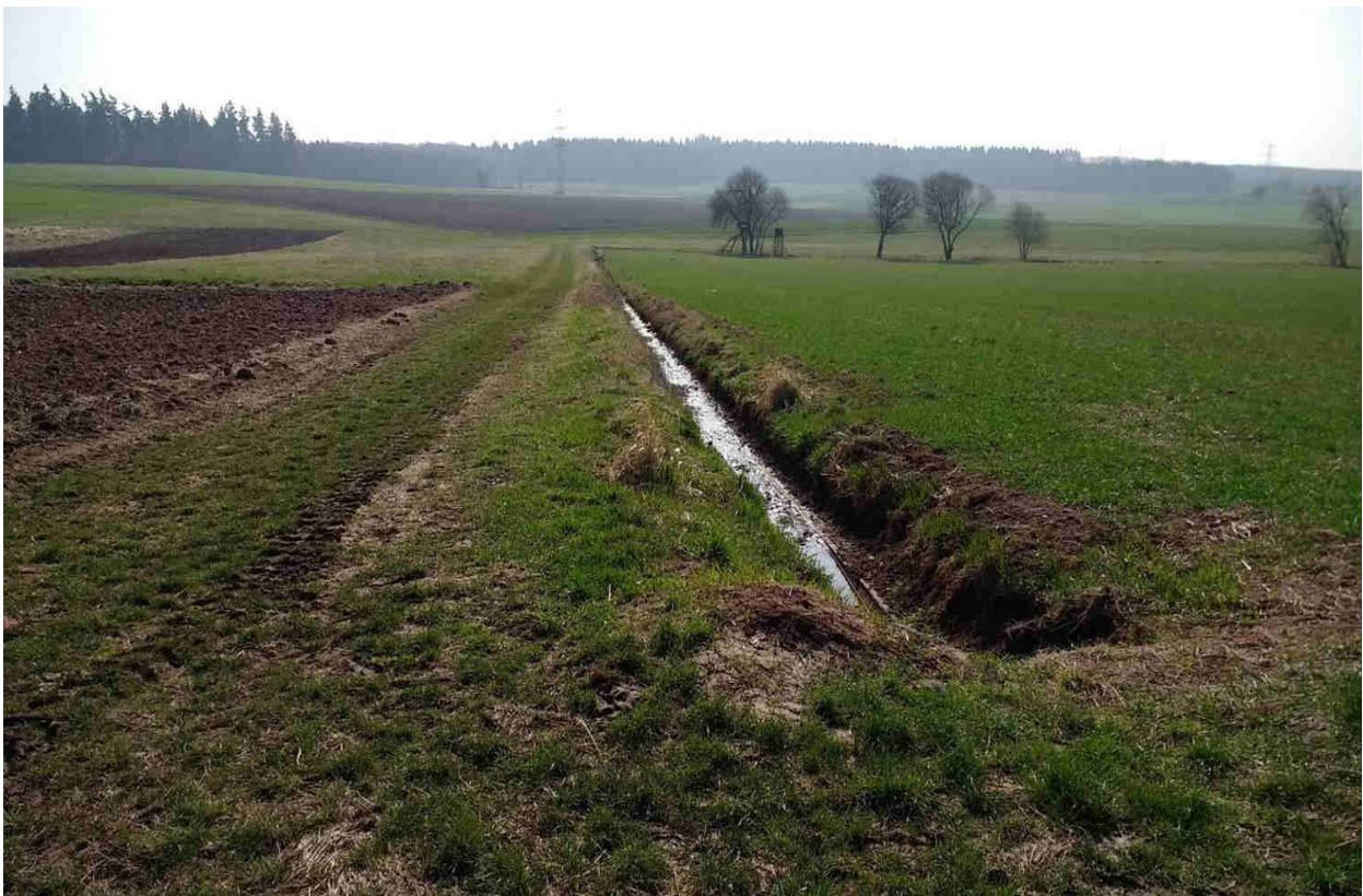
Abbildung 80: Graben „In den Münchwiesen“/ Rückhaltemaßnahmen
