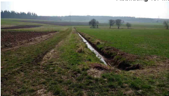
Abbildung 20: Münchwiesenbach, Gräben oberhalb Wege Durchlass
