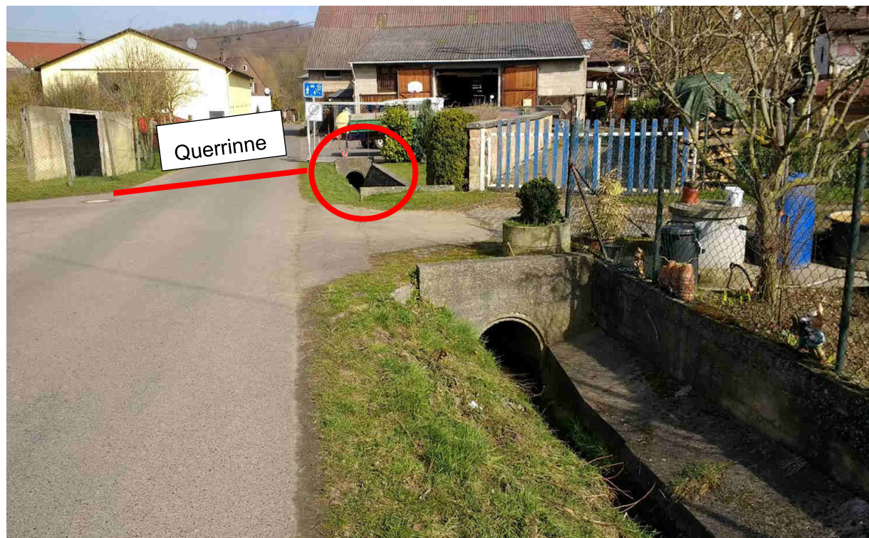
Abbildung 64: Einlaufbereich Hagenbach/ Querrinne und Einlaufbauwerk
