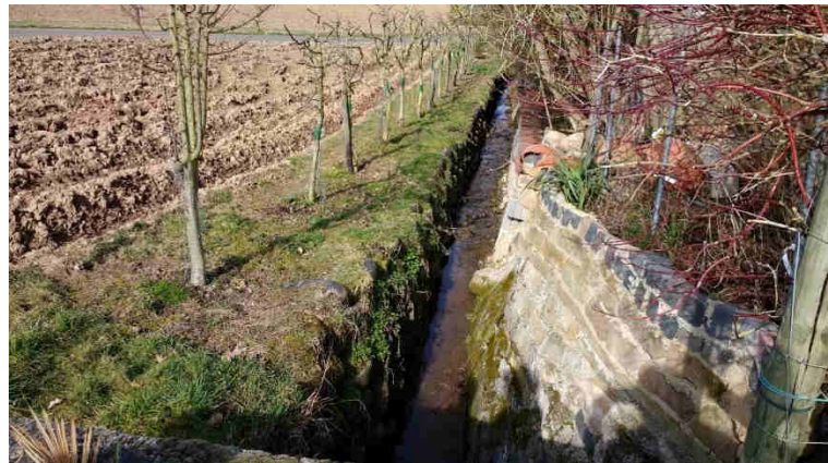
Abbildung 29: Hagenbach, eingengt und befestigt
