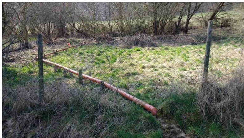
Abbildung 47: Teich mit provisorischer Ableitung
