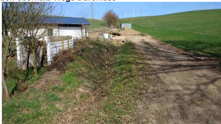
Abbildung 21: Münchwiesenbach, Seitengraben verrohrt
