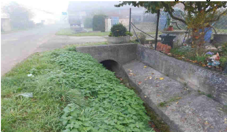
Abbildung 33: Hagenbach, Trapezprofil und Rohrdurchlass
