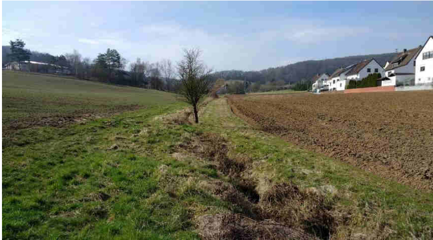
Abbildung 16: Rohrbach Abschnitt unterhalb der Landstraße. Gradliniger Verlauf, Ausbau mittels Halbschalen
