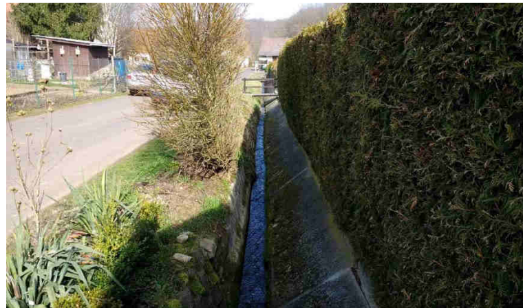
Abbildung 32: Hagenbach, Trapezprofil
