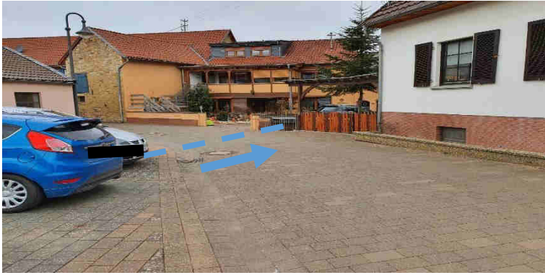
Abbildung 35: Hagenbach, Verrohrung und Auslaufbereich
