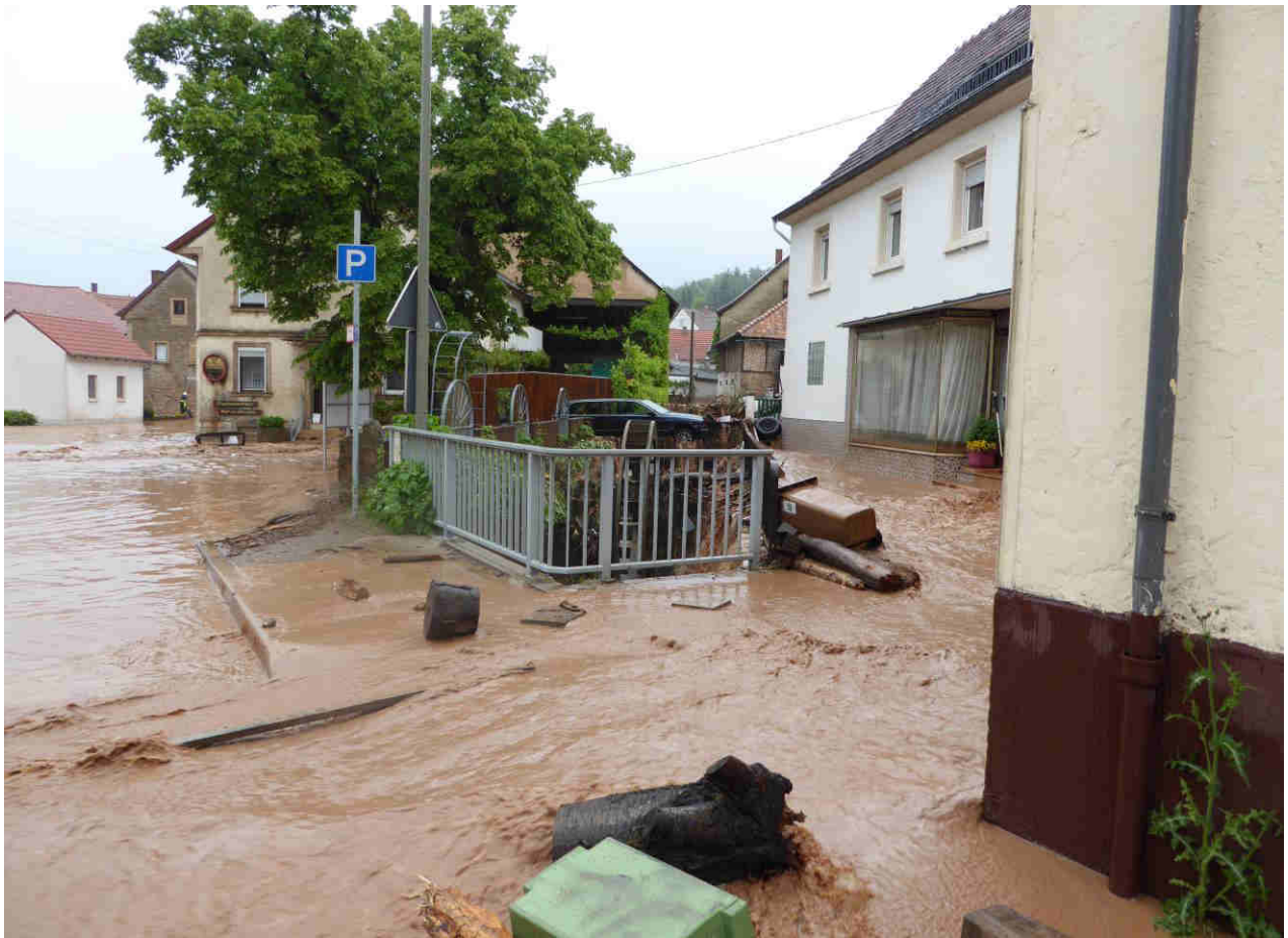
Abbildung 10: Hauptstraße 6:58 Uhr Gewässerbett führt kein Wasser mehr (Blick gegen Fließrichtung), 30.05.2016 [6]
