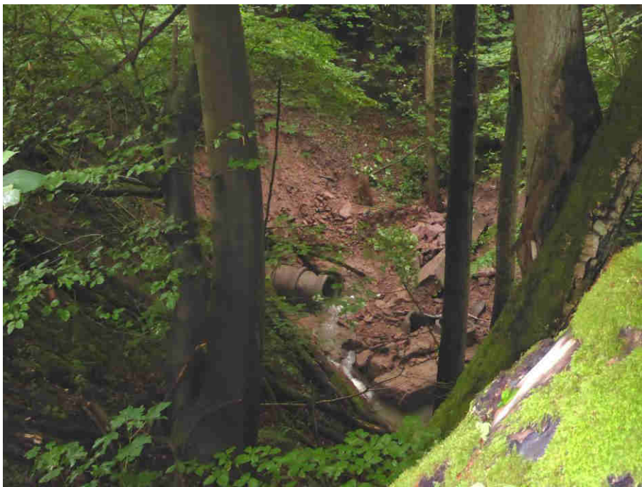
Abbildung 33: Leischbach Dammverrohrung DN1000 (Blick gegen Fließrichtung), 02.06.2016 [6]
