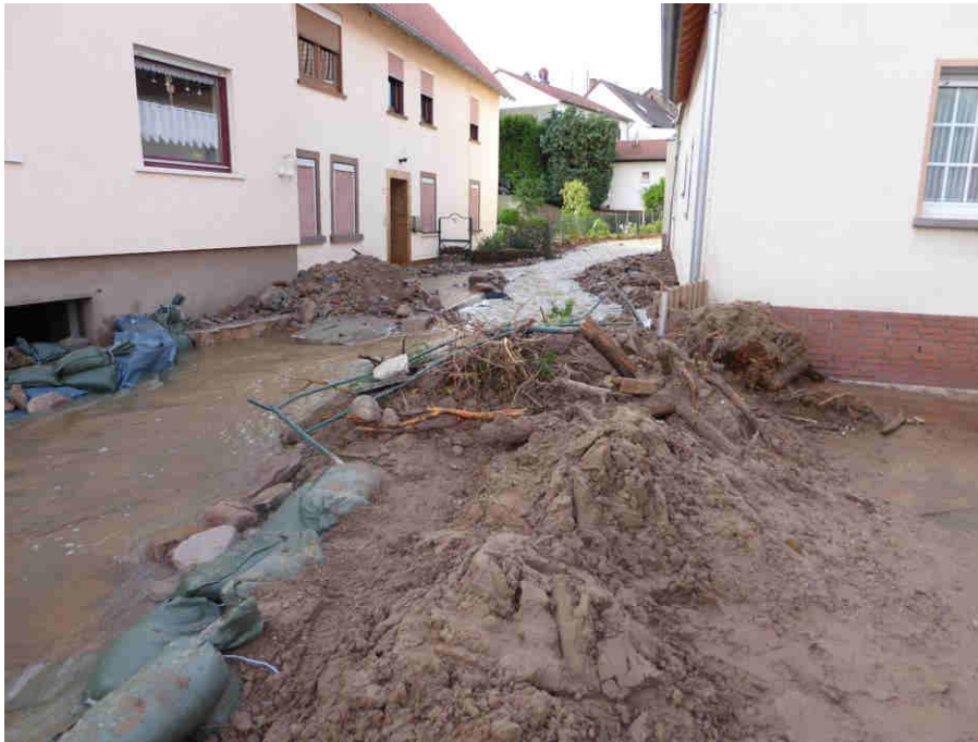
Abbildung 19: Ausgeuferter Leischbach in Kanalstraße 6:40 Uhr (Blick gegen Fließrichtung), 31.05.2016 [6]
