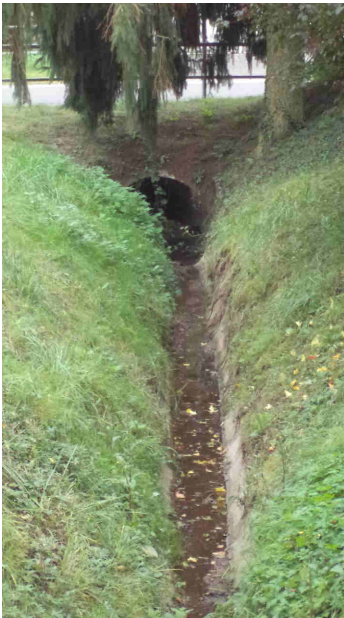
Abbildung 44: Verrohrung B 48 (Blick in Fließrichtung) [8]
