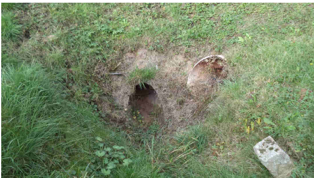
Abbildung 38: Verrohrung DN400 B48 (Blick in Fließrichtung) [8]
