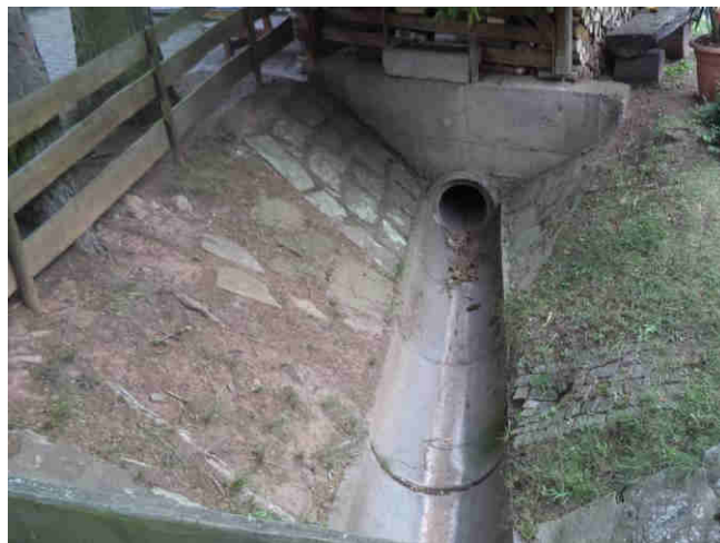
Abbildung 43: Verrohrung Einlaufbereich, Blick in Fließrichtung [8]
