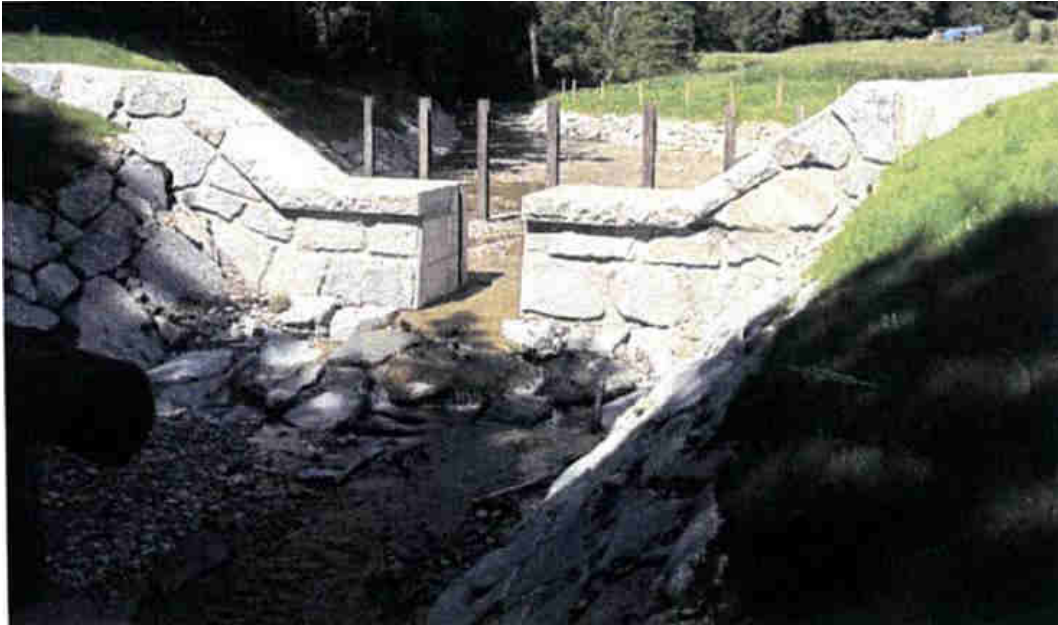
Abb. 3: Ausführungsbeispiel für einen Geröllrückhalt im Hauptschluss
