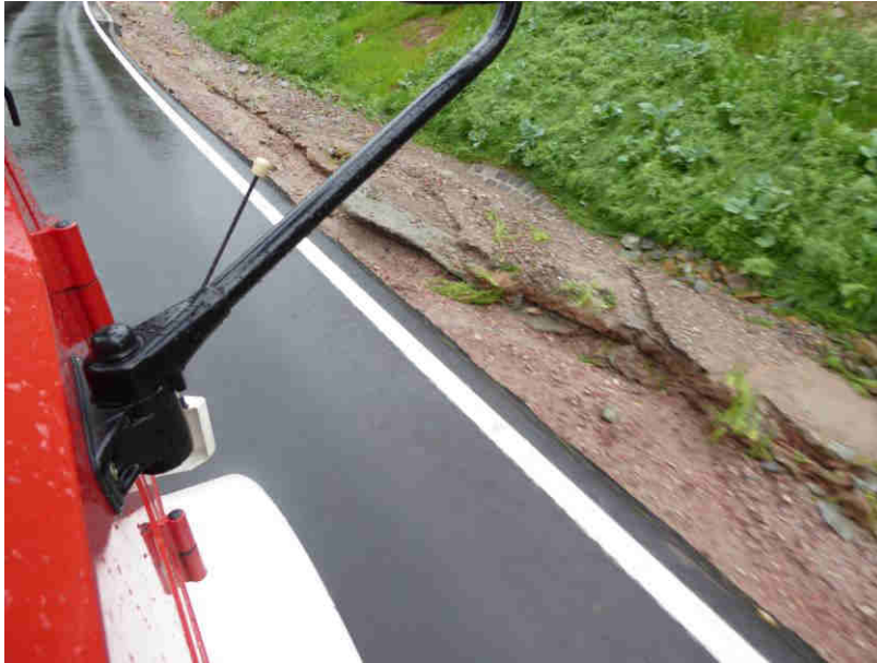
Abbildung 13: Ausgewaschene Bankette an der B420 10:44 Uhr, 30.05.2016 [5]
