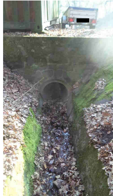
Abbildung 17: Einlauf Ende Geröllfang; 16.02.2017
