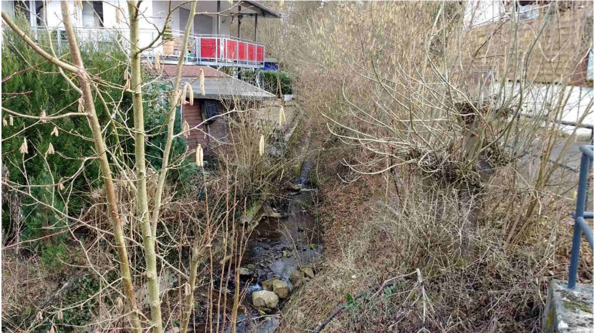
Abbildung 34: Eingeengtes Abflussprofil
