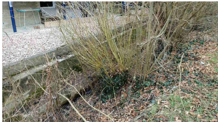
Abbildung 14: Uferbewuchs ragt in Bachbett hinein; 23.02.2017, 12:16; Eilbach
