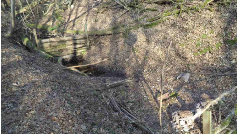
Abbildung 18: Zugesetzter Geröllfang; 16.02.2017; Am Rödelstein
